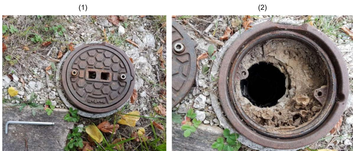
**Figure 27** Exemple de capot ne permettant pas de pose correcte d'un échantillonneur de type iFLUX : 1) photo du capot carrossable, 2) photo de la vis empêchant la descente de l'outil dans le forage.
